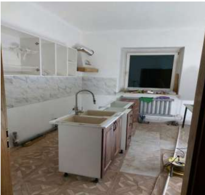
Die Küche – ebenfalls noch nicht ganz fertig
