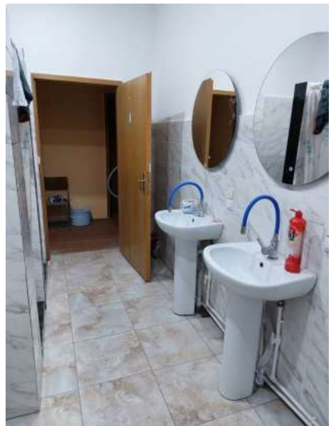
Das Badezimmer, bis auf die Trennwand für die Toilette fertig
