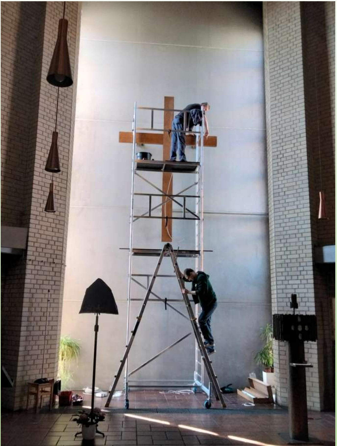
März 2026: In der Kirche St. Maximilian Kolbe reparieren Andreas Schiwiek und Johannes Prziwarka die Beleuchtung des großen Kreuzes im Altarraum.
